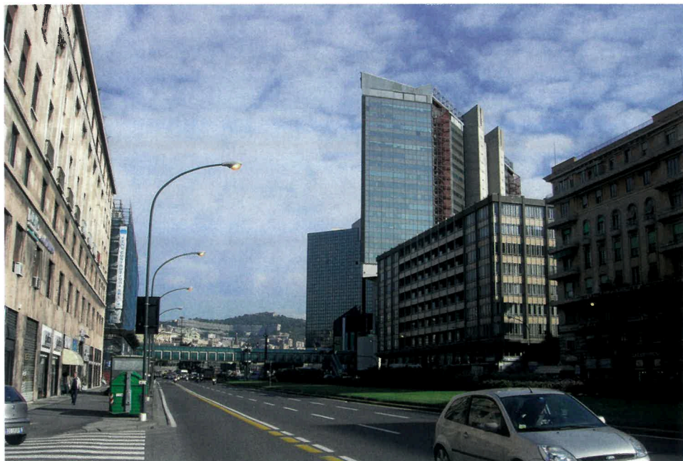
Genova, il viale Brigata Bisagno, primo tratto della copertura del torr. Bisagno tra la ferrovia e il mare. A destra, gli edifici dell'ex "Corte Lambruschini"; nello sfondo, sulla collina, il noto complesso edilizio detto "il Biscione"
