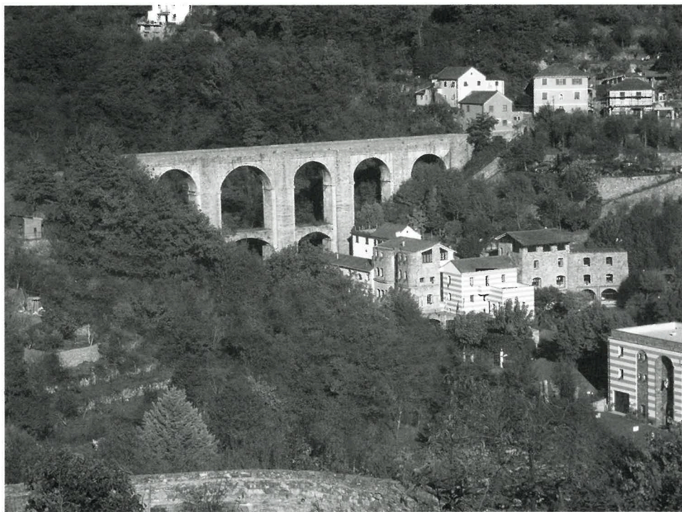
Struppa: il ponte-canale sul rio Tòrbido, l'opera più imponente del prolungamento (iniziato nel 1623) dell'acquedotto storico di Genova. Per la scarsa stabilità del versante destro, il ponte venne rinforzato nel XIX° secolo.
