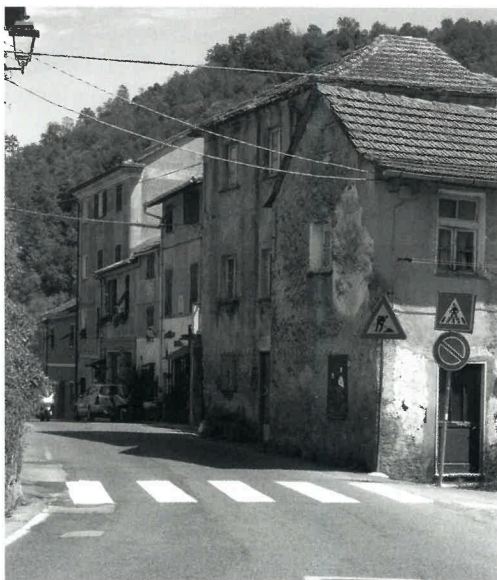
Vecchie costruzioni a Vigo di Cerànesi
