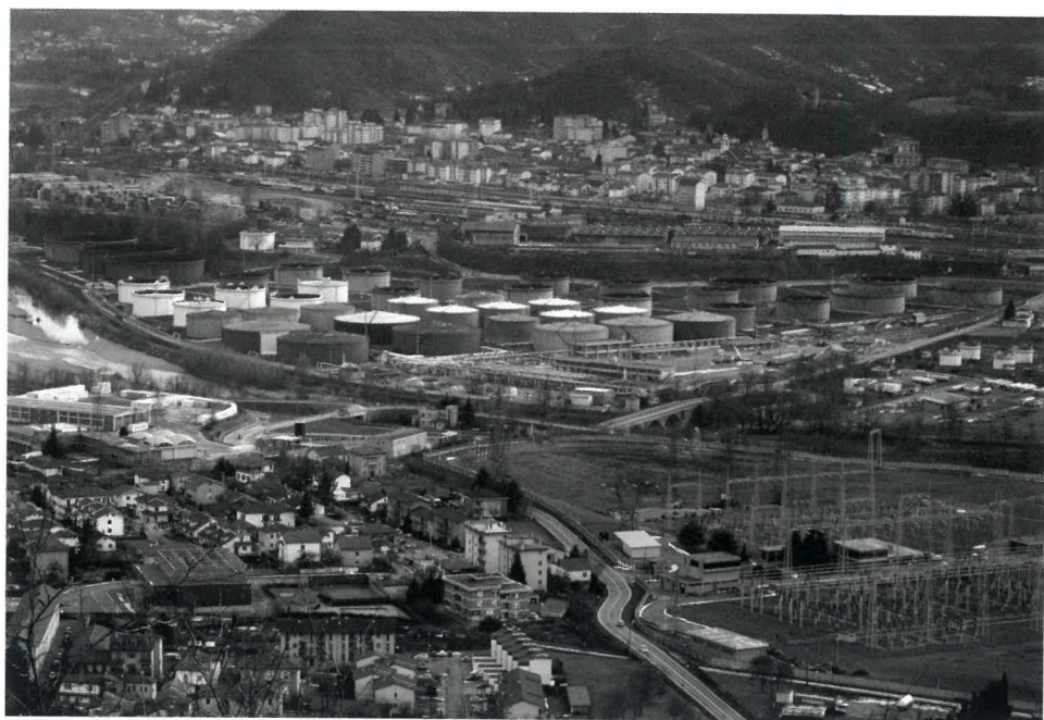
Vignole Borbera e, al di là dello Scrivia, gli impianti petroliferi della ERG e l'abitato di Arquata.
