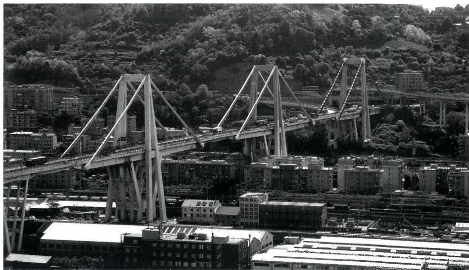
Il viadotto sul Polcévera, imponente struttura lunga 1.182 metri, costruita su tre tiranti in cemento armato alti circa 90 metri, progettata dall'ing. Riccardo Morandi ed inaugurata nel 1967.
