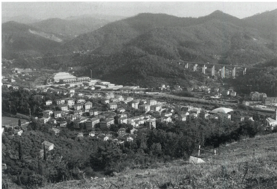
Il centro di Casarza visto da nord, dalle colline di Vèrici. Oltre il corso d'acqua, la zona industriale e, in alto, l'autostrada Genova-Rosignano
